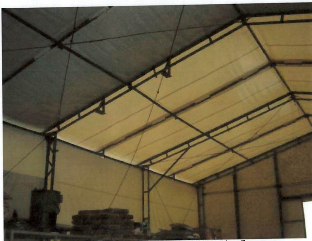
Foto 3.12 - Lonas do galpão, limpas, melhorando a limpeza
