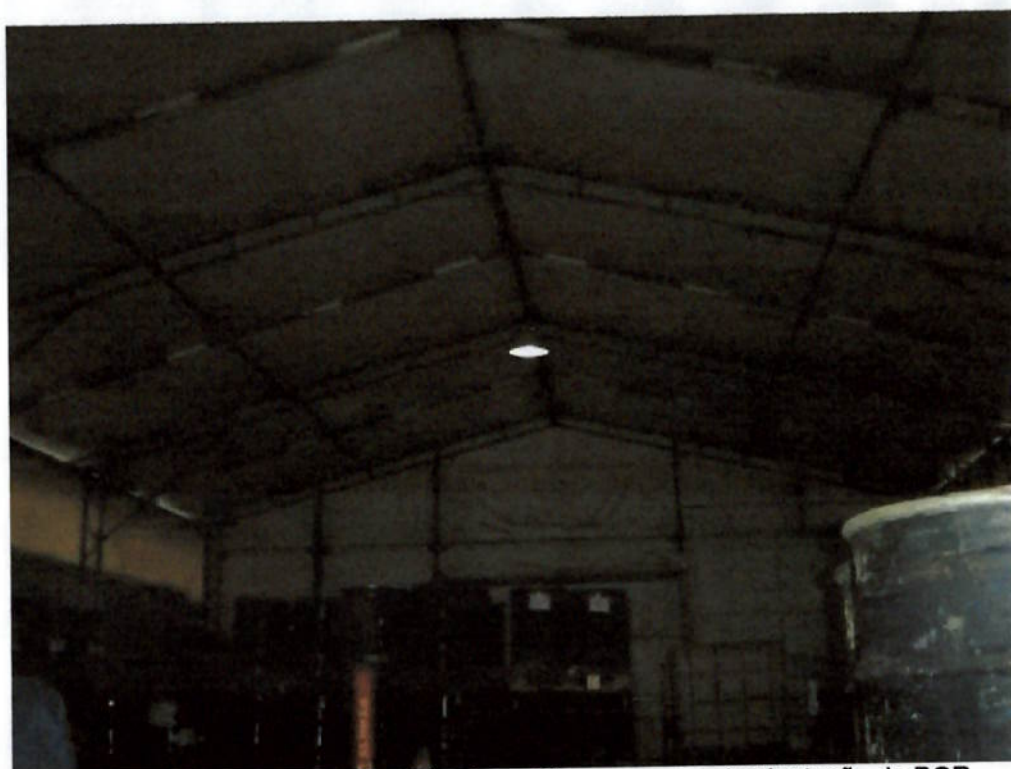
Foto 3.11 - Iluminação do galpão de resíduos antes, da implantação do PGR
