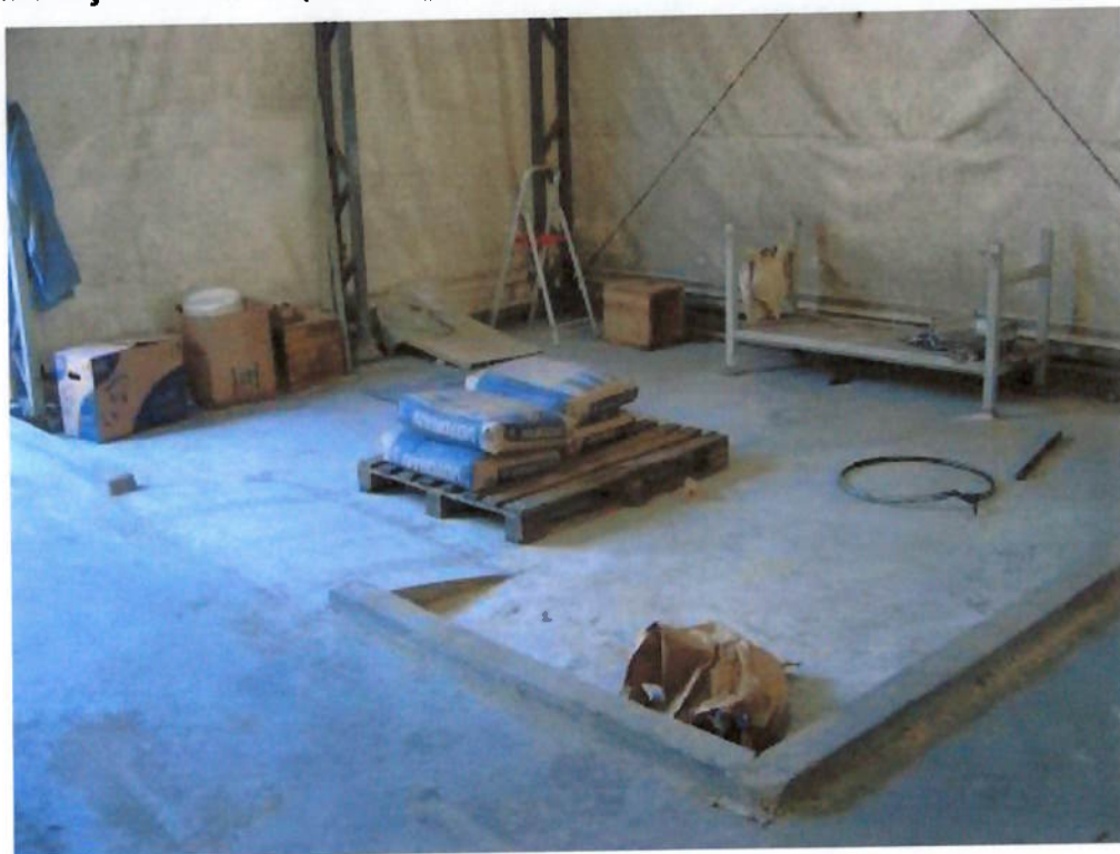
Foto 3.17 - Bacia de contenção de óleo em construção
