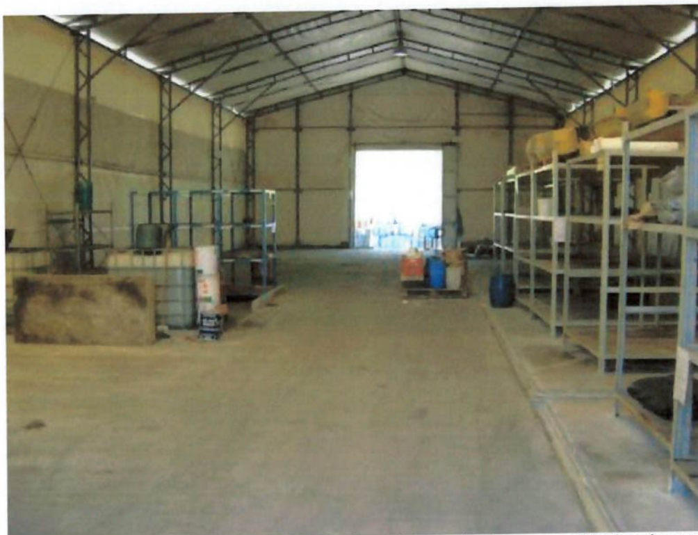
Foto 3.4 - Galpão de resíduos em implantação, com sistema de drenagem e bacias de contenção, caracterizando um local coberto e ventilado.
