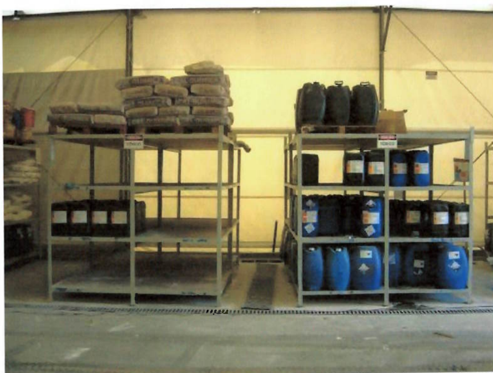
Foto 3.5 - Prateleiras do galpão – resíduos com rótulos e identificação e sistema de drenagem com grelhas
